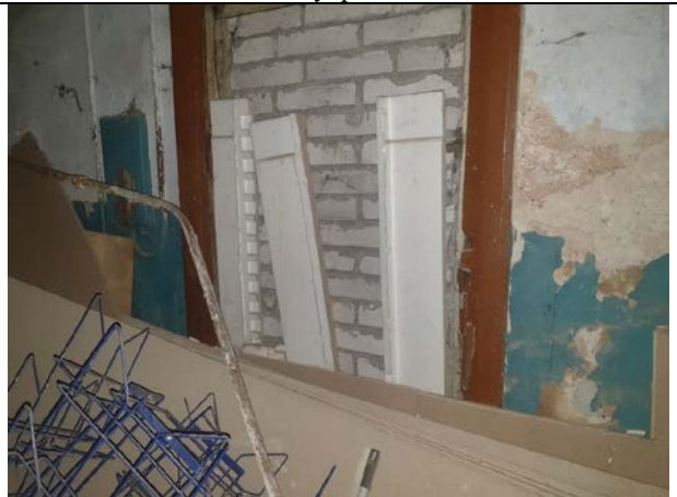
Фото № 14 – Внутреннее состояние
