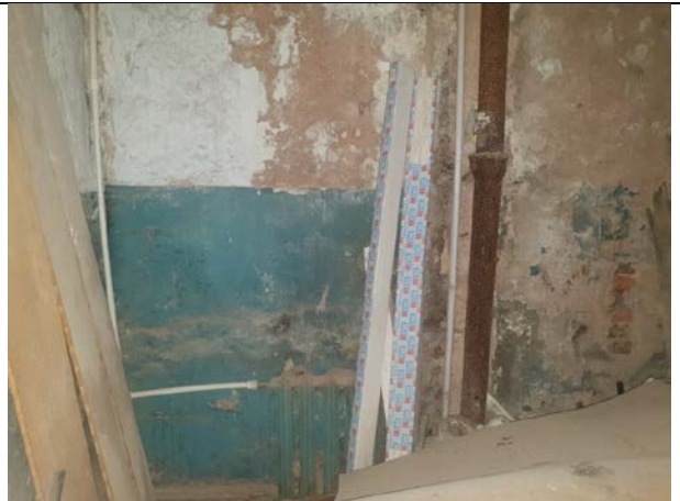
Фото № 10 – Вход в помещение
