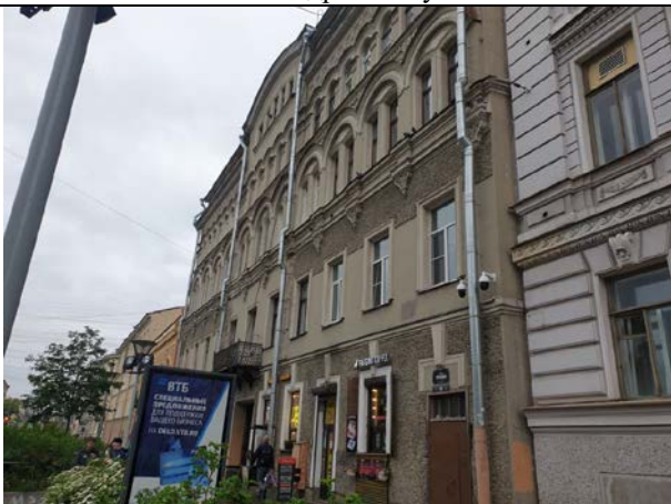
Фото № 5 – Здание, в котором находится объект оценки
