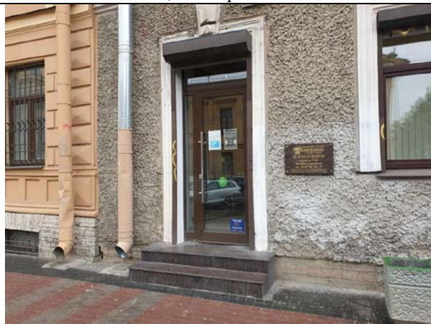
Фото № 6 – Вход в помещение (общий с улицы)
