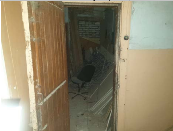
Фото № 9 – Вход в помещение
